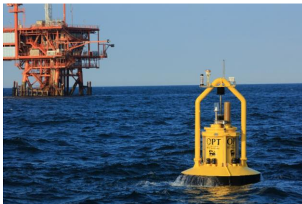
Fig. 3 – Dispositivo per la conversione di energia ondosa PowerBuoy, prodotto dall’azienda americana OPT ed installato da Eni presso la piattaforma Amelia a Ravenna nell’ambito del progetto PLaCE ( https://bluegrowth-place.eu/?p=1081 )
